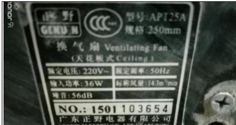
图 3-6 伽玛刀机房通风设施及换气扇铭牌
