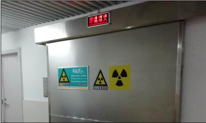
图 3-1 医院辐射工作制度、工作状态指示灯及电离辐射标志照片
